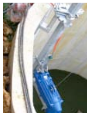
Agitateur sur axe à hauteur réglable. Photo Solagro.
