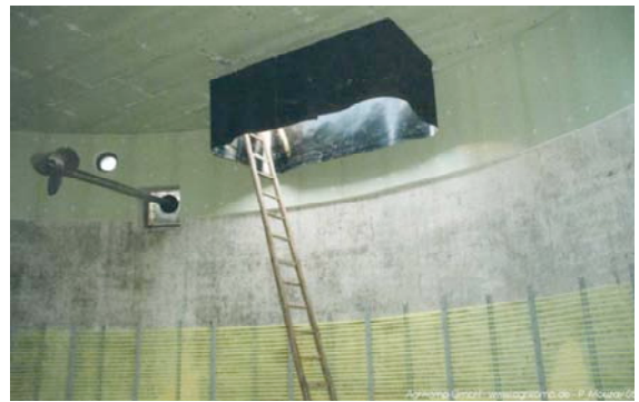
Chauffage par réseau de tubes ; agitation par un malaxeur mécanique. Photo AGRIKOMP
